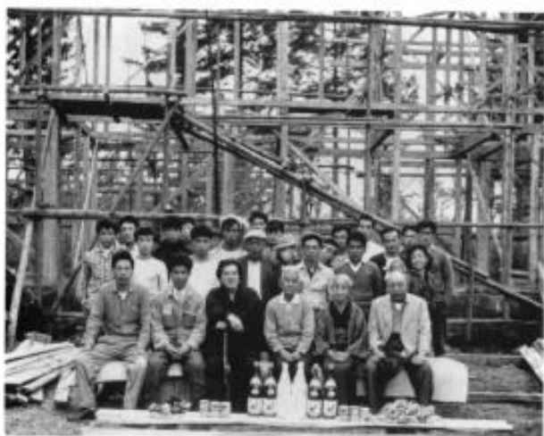
建築中の研究所 1960年（昭和35年）
